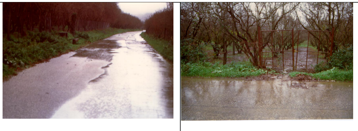
Figura 7.9: Le strade contribuiscono al deflusso e, alla prima soluzione di continuità, lo scaricano nei noccioleti a valle, da cui si incanala verso il lago.
